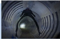
De tunnel door
